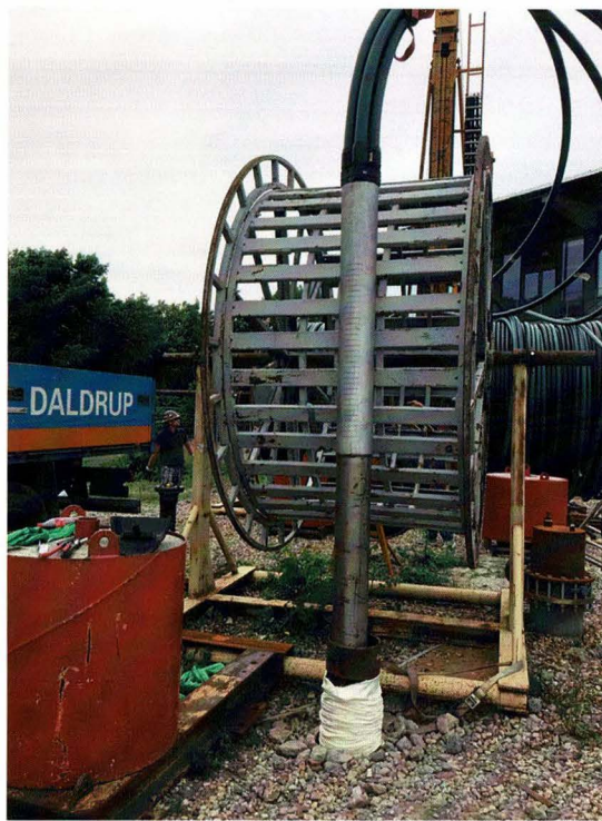
Bild 5 – oben: Schnitzzeichnung durch die Doppel-U-Sonde DA 75 mit Ausbau des Bohrlochs im Niveau der Schachtfüllsäule. Unten: Sondenfuß mit Gewicht und Schutzrohr für Fußventile beim Einbau.
